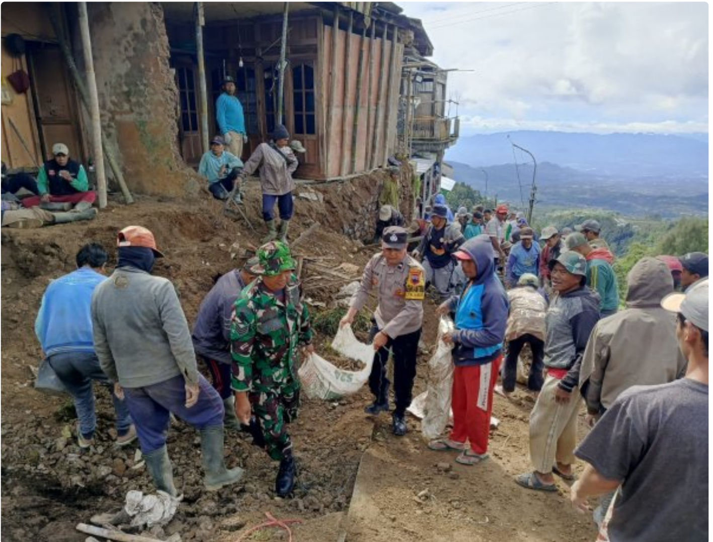
(Foto Dokumen) : Gotong royong pembersihan material longsor
